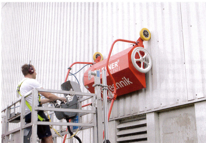
Marco Kreuzberger reinigte die Fassade in Bahnen von oben nach unten, damit das Schmutzwasser nicht über die gereinigte Fläche läuft.
